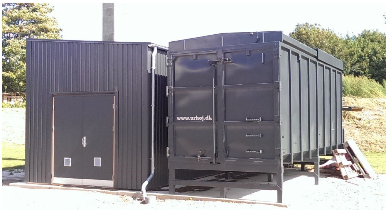
I модуль - котёл REKA 250 кВт II- контейнер для топлива для пеллет и щепы, «живой пол»
