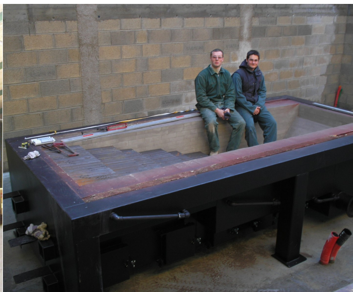
Установка фундамента котла, топливо - солома
