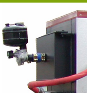
Ударные взрывы - очистка труб
