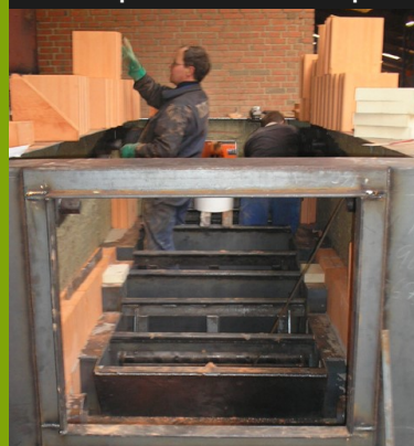
Строительство фундамента котла, камера сгорания
